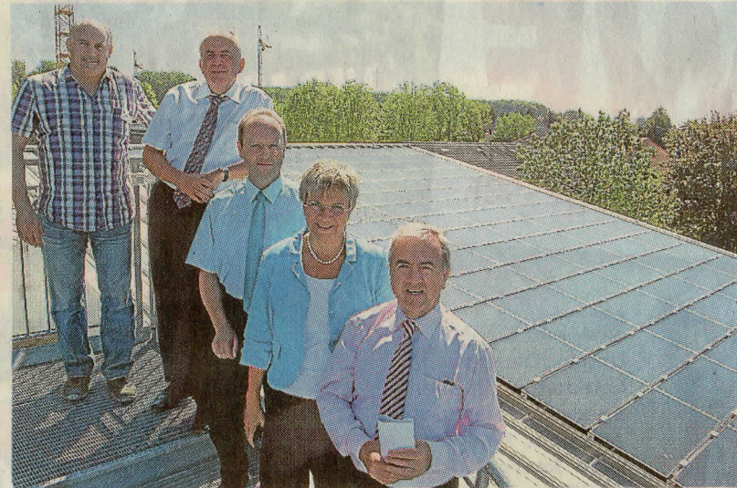
Landrat Schick und Schulleiterin (von rechts) Lerch freuen sich über die Photovoltaikanlage auf dem Dach des Gymnasiums.
